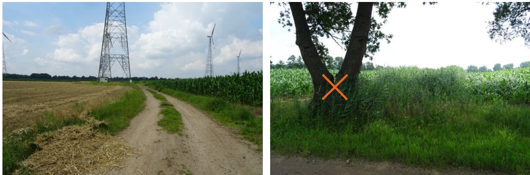
Abbildung 54 Bestehende Zuwegung zum Standort der WEA Din02 (links) sowie (doppelstämmiger) Einzelbaum gegenüber der WEA Einfahrt (rechts)
