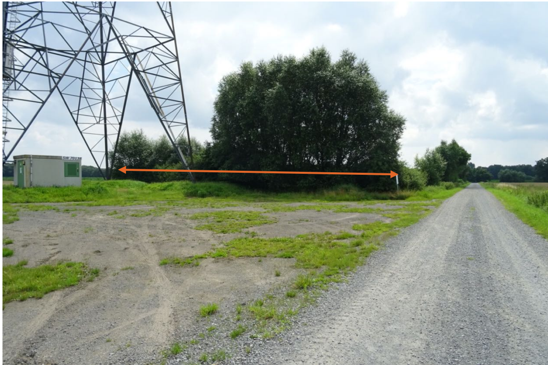
Abbildung 60 Kranstellfläche der WEA Din04 mit der angrenzenden Gehölzpflanzung
