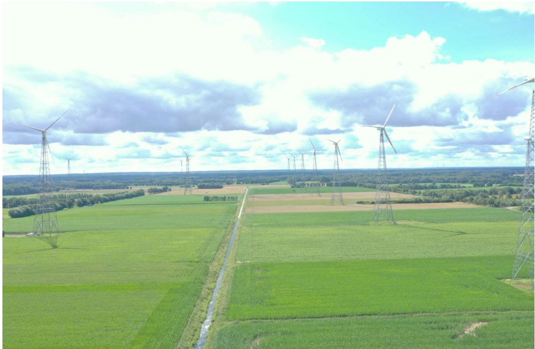
Abbildung 28 Stark begradigter Bünne-Wehdeler Grenzkanal im Zentrum des UG
