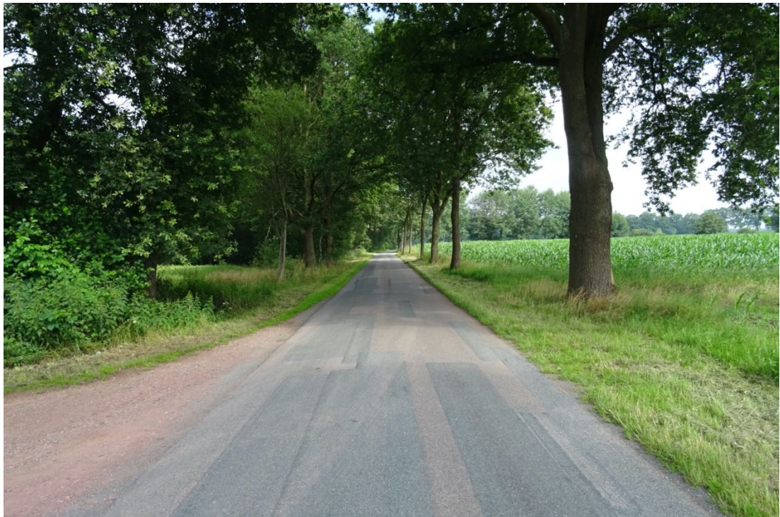
Abbildung 37 Wehdelerfeldstraße im nördlichen UG (Blickrichtung Norden)
