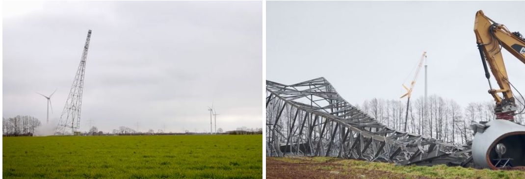
Abbildung 5 Bilder der Sprengung (links) und Demontage eines Gittermastturmes (rechts) einer Vestas V47 in Bremen © Deutsche Windtechnik
