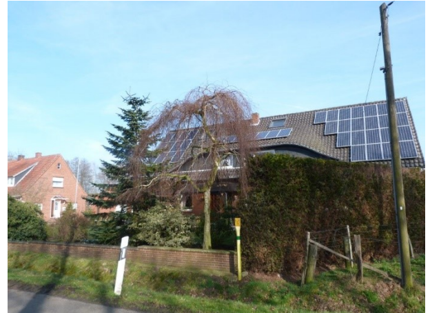
Abbildung A.20: IO 60, Lechterker Straße 70
