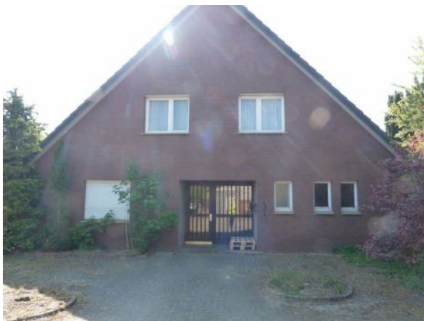
Abbildung A.3: IO 9, Quakenbrücker Straße 106
