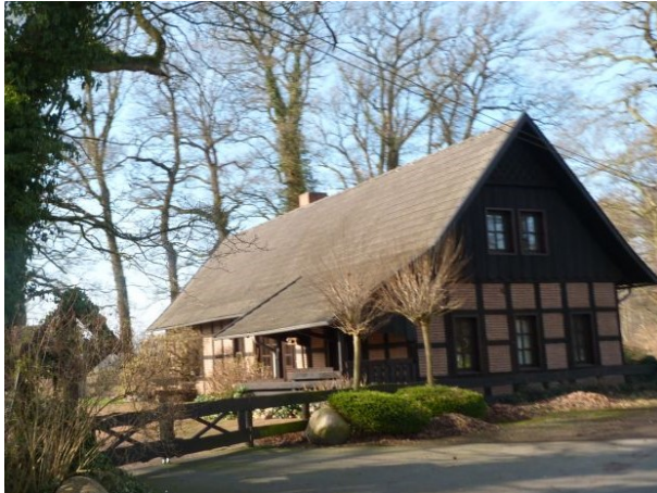
Abbildung A.19: IO 59, Lechterker Straße 23
