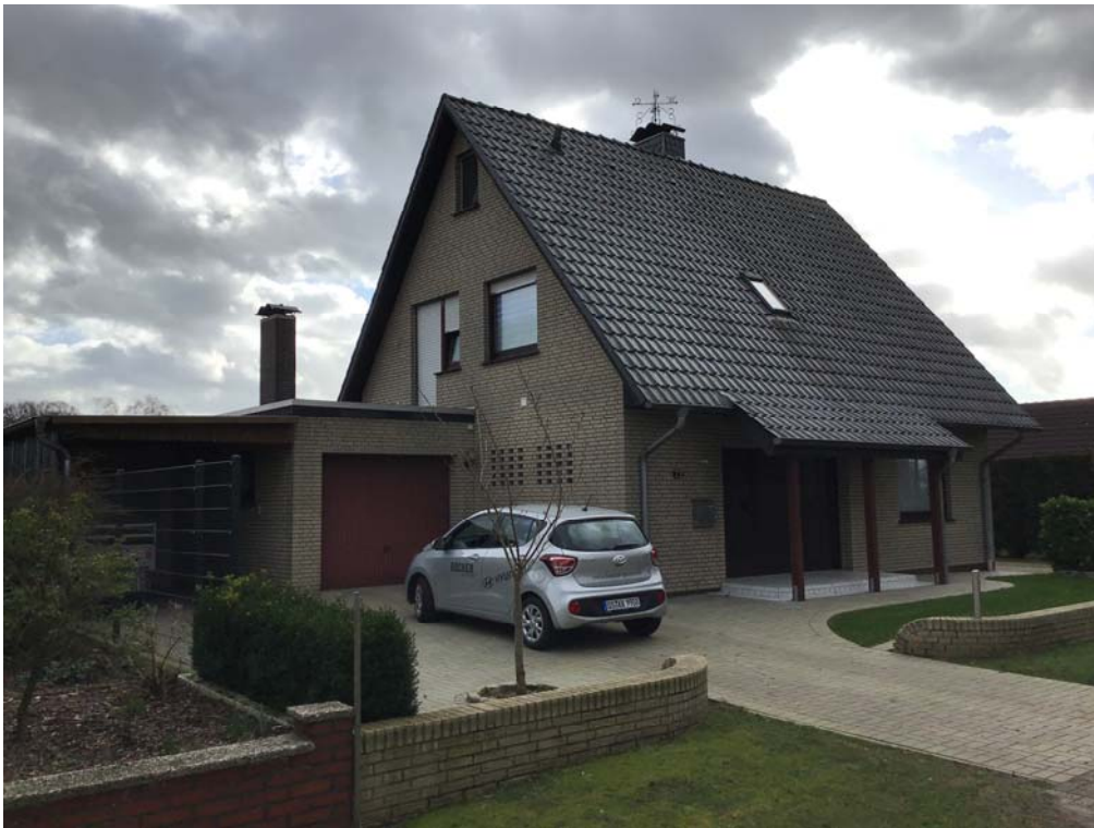
Foto 43: Blick auf die in Richtung Nordosten ausgerichtete Hausfront des Wohnhauses W41
