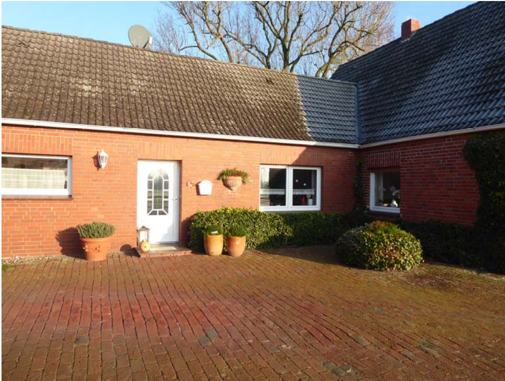
Foto 7: Blick auf den westl. Teil der nach Süden ausgerichteten Hausfront des Wohnhauses W05
