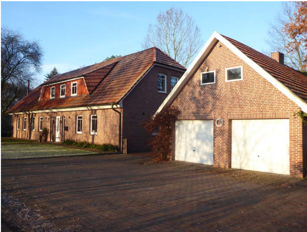
Foto 29: Blick auf die in Richtung Nordosten und Südosten ausgerichteten Hausfronten des Wohnhauses W34 und dem vorgelagerten Nebengebäude
