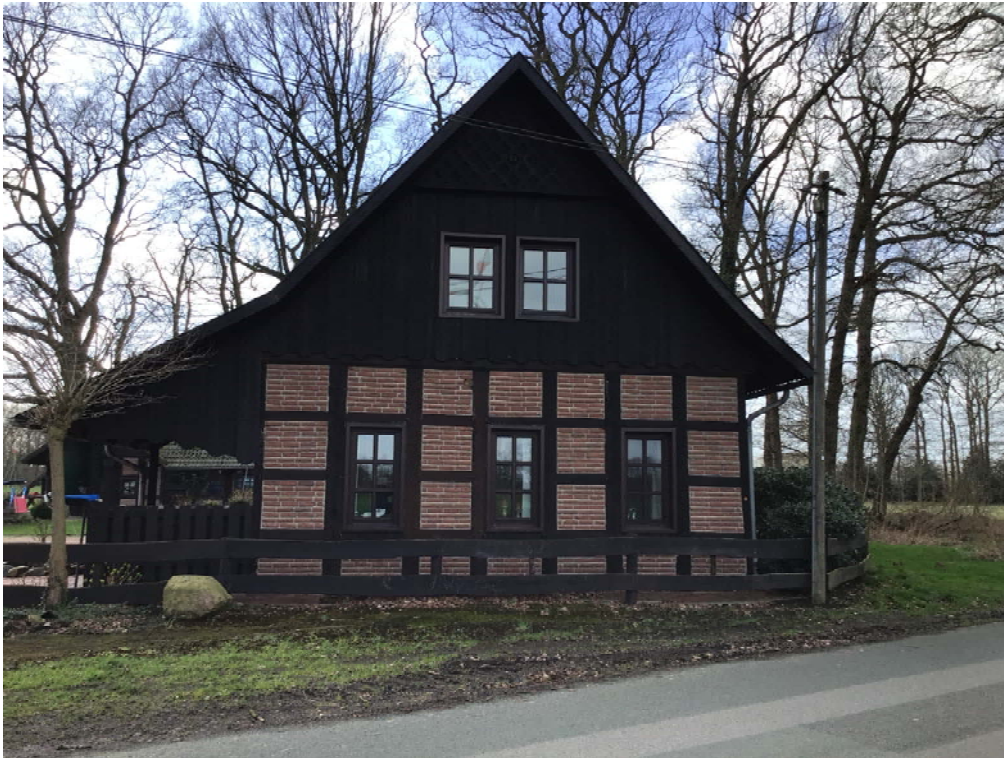
Foto 33: Blick auf die in Richtung Nordosten ausgerichtete Hausfront des Wohnhauses W36
