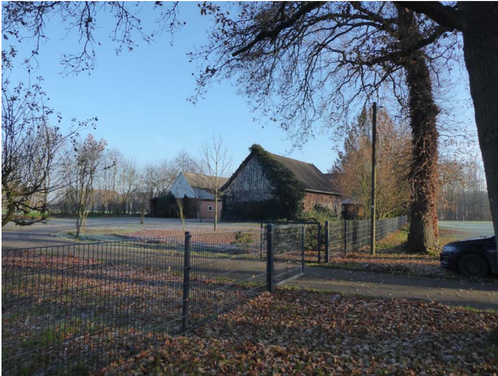
Foto 17: Blick auf zwei dem Wohnhaus W08 westlich vorgelagerten Nebengebäude
