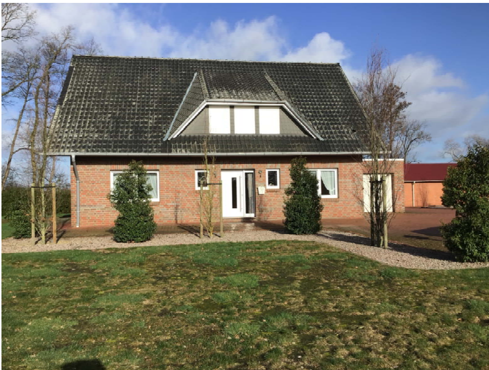
Foto 14: Blick auf die in Richtung Südosten ausgerichtete Hausfront des unbewohnten Wohnhauses W06
