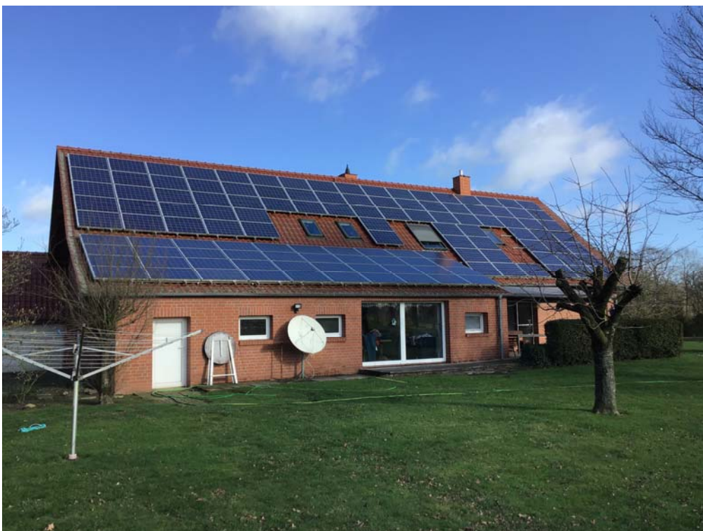
Foto 20: Blick auf die in Richtung Süden ausgerichtete Hausfront des Wohnhauses W09
