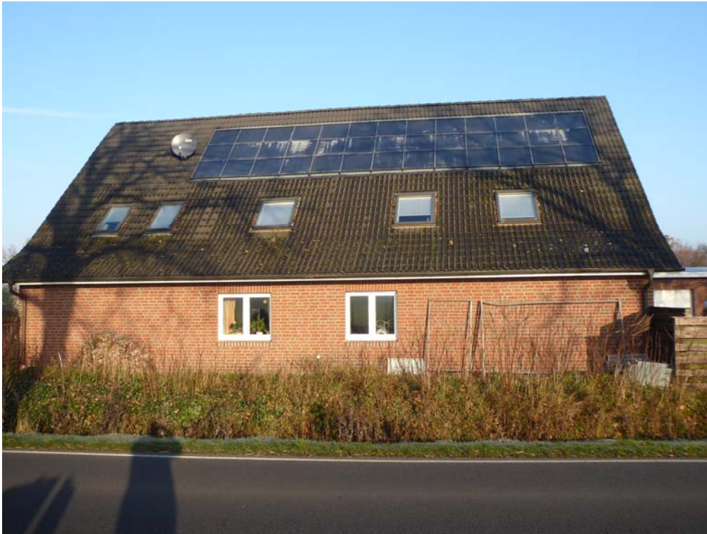
Foto 5: Blick auf die in Richtung Süden ausgerichtete Hausfront des Wohnhauses W04
