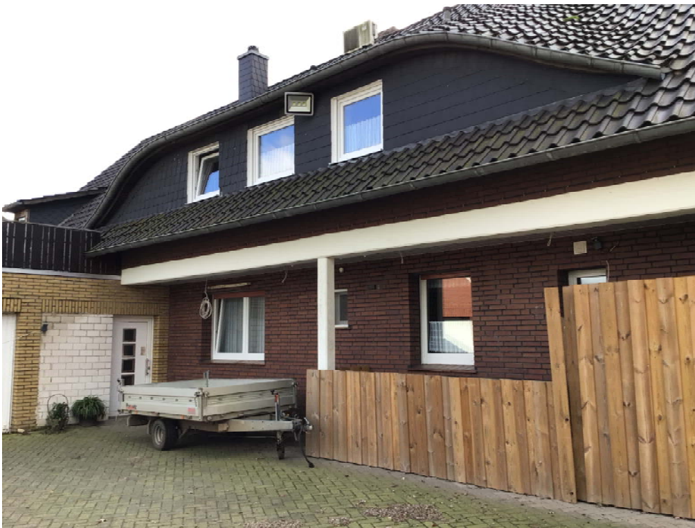
Foto 35: Blick auf die in Richtung Nordosten ausgerichtete Hausfront des Wohnhauses W37
