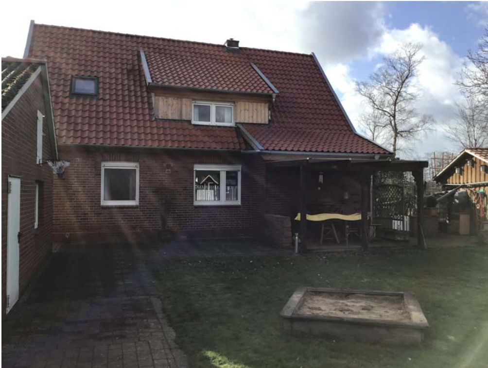
Foto 37: Blick auf die in Richtung Nordosten ausgerichtete Hausfront des Wohnhauses W38
