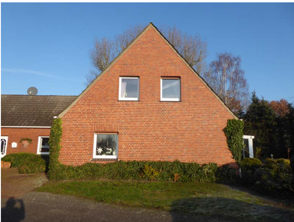
Foto 8: Blick auf den östl. Teil der nach Süden ausgerichteten Hausfront des Wohnhauses W05
