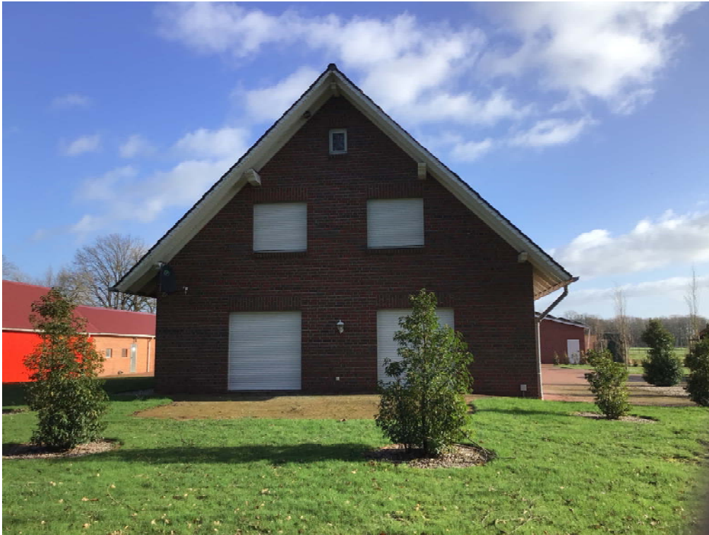
Foto 13: Blick auf die in Richtung Südwesten ausgerichtete Hausfront des unbewohnten Wohnhauses W06
