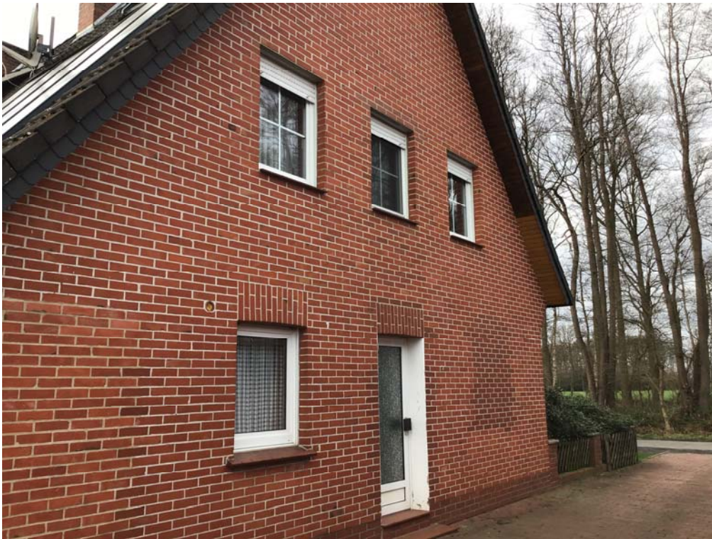
Foto 41: Blick auf die in Richtung Nordosten ausgerichtete Hausfront des Wohnhauses W40
