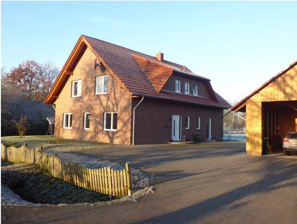
Foto 27: Blick auf die in Richtung Nordosten und Südosten ausgerichteten Hausfronten des Wohnhauses W33
