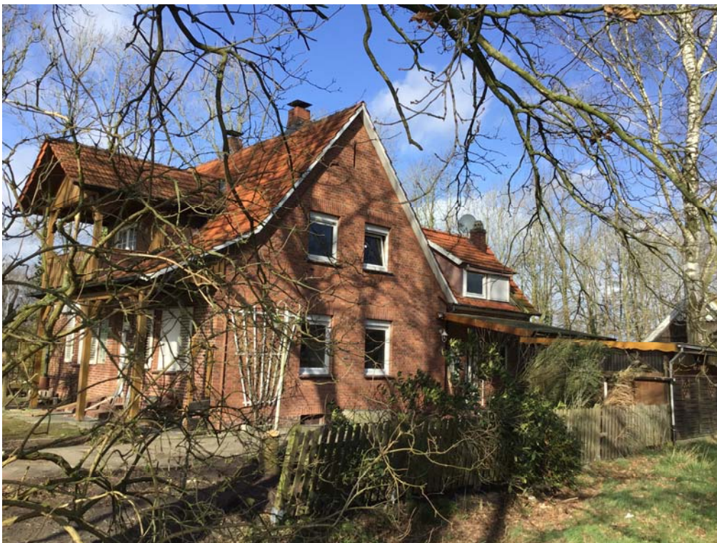
Foto 32: Blick auf die in Richtung Südosten ausgerichtete Hausfront des im Umbau befindlichen Wohnhauses W35
