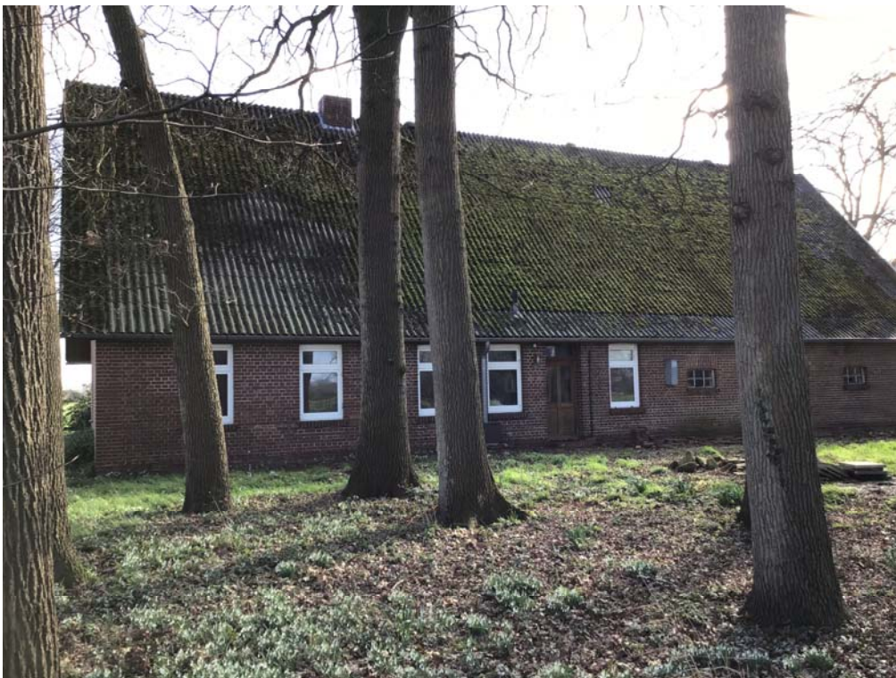
Foto 22: Blick auf die in Richtung Nordwesten ausgerichtete Hausfront des unbewohnten Wohnhauses W29
