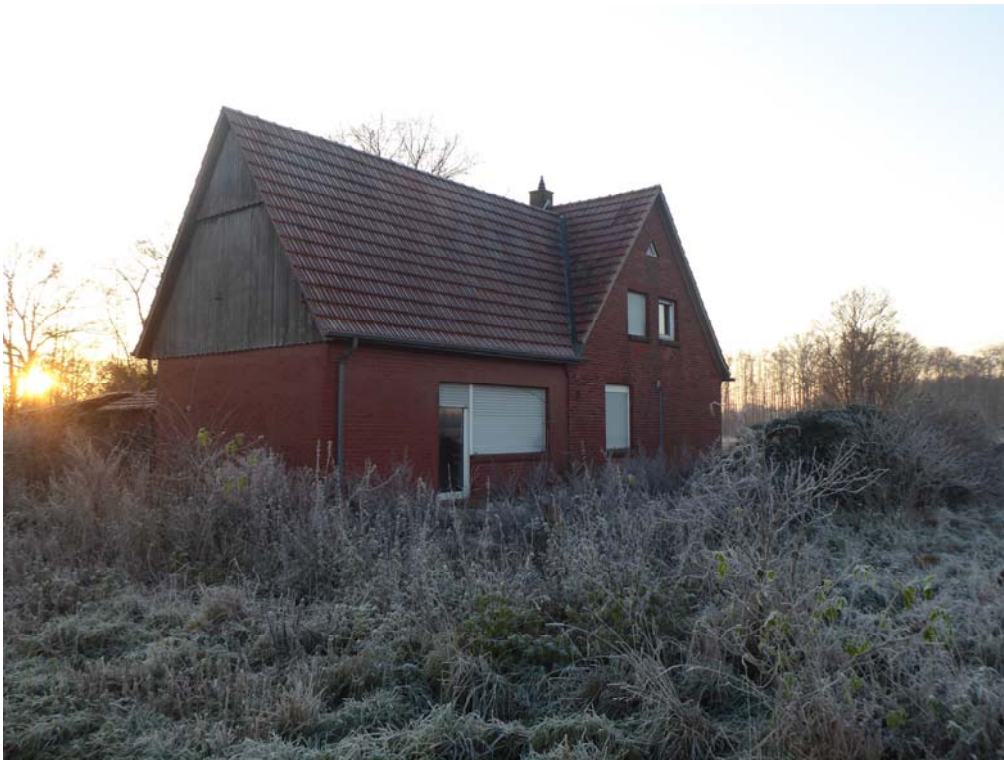
Foto 23: Blick auf die in Richtung Nordwesten ausgerichtete Hausfront des unbewohnten Wohnhauses W30
