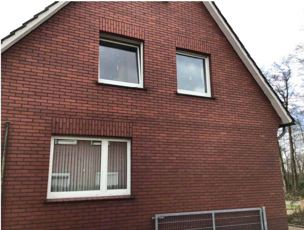
Foto 45: Blick auf die in Richtung Nordosten ausgerichtete Hausfront des Wohnhauses W42
