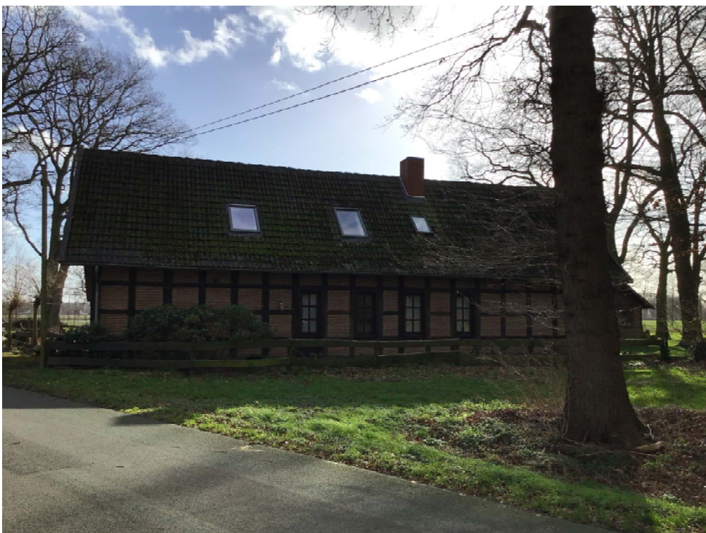
Foto 34: Blick auf die in Richtung Nordwesten ausgerichtete Hausfront des Wohnhauses W36
