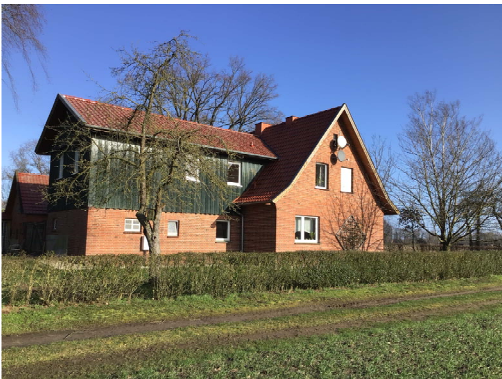
Foto 12: Blick auf die in Richtung Südosten ausgerichtete Hausfront des Wohnhauses W05b
