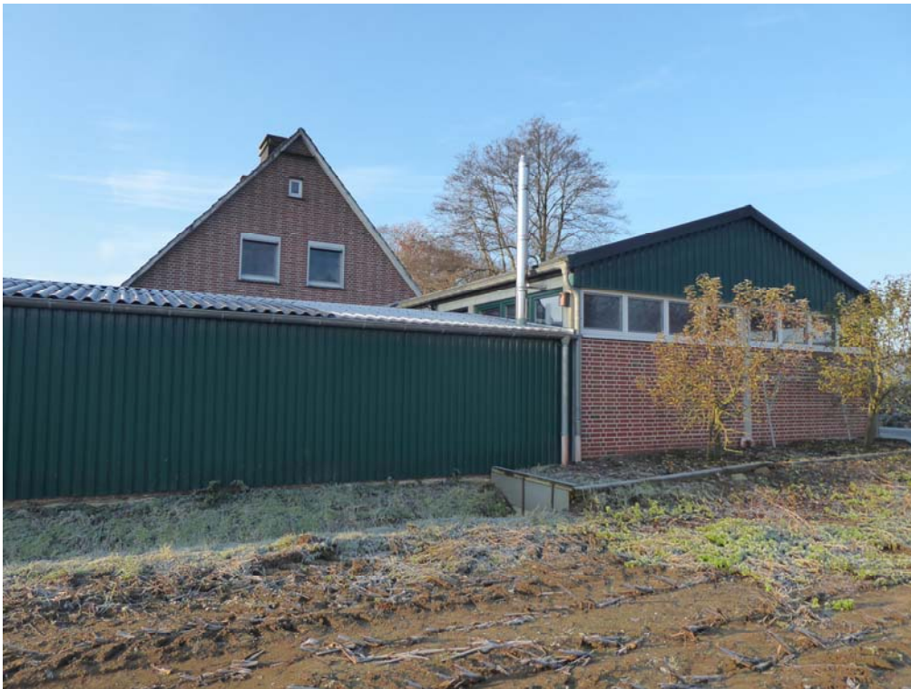
Foto 48: Blick auf die in Richtung Nordosten ausgerichtete Hausfront des Wohnhauses W43 und dem vorgelagerten Nebengebäude der Mosterei
